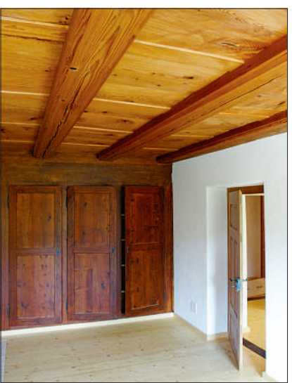
Einbauschränke und Deckenlage wurden aufgefrischt
